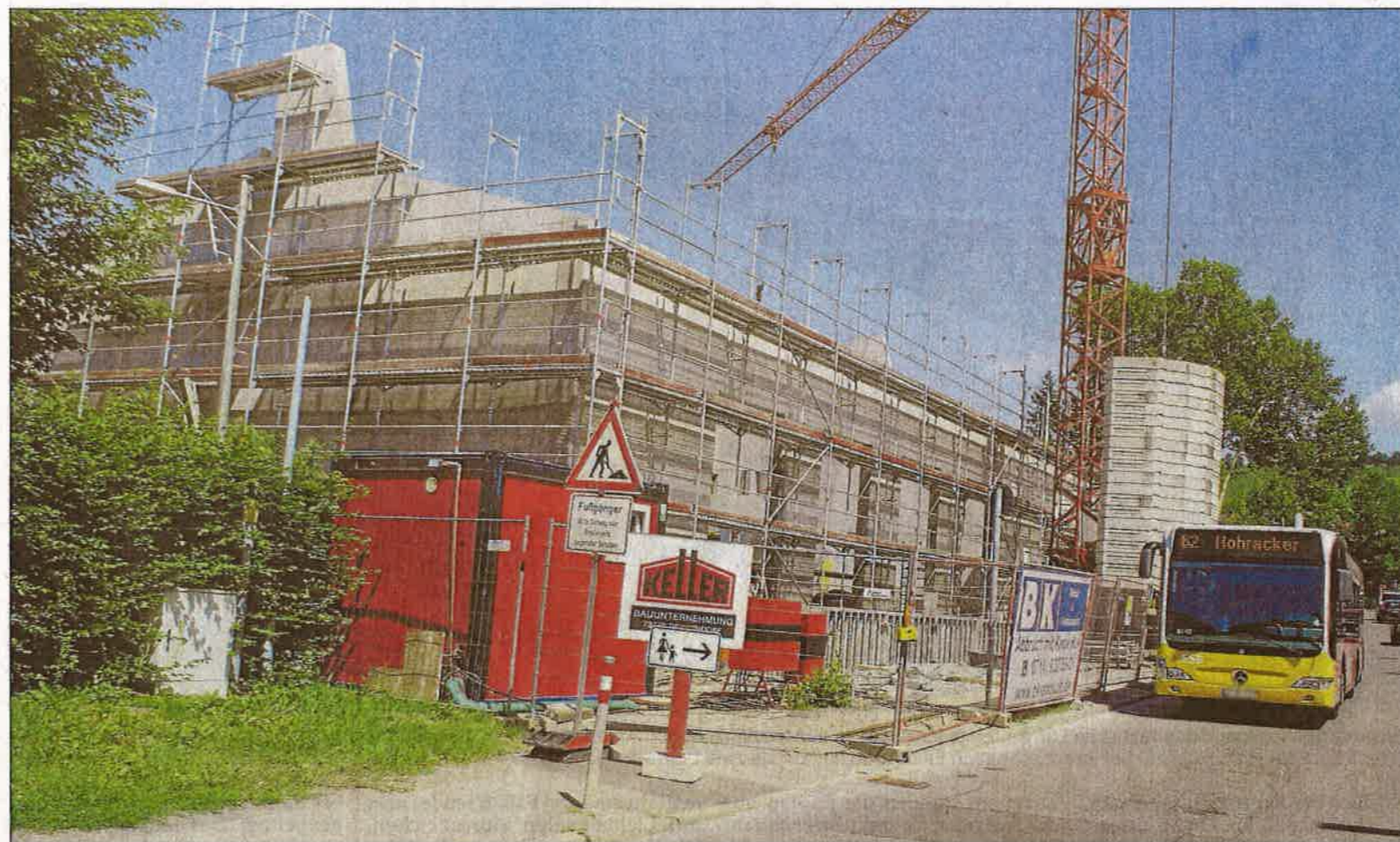
Die Haltestelle Terlaner Straße in Fahrtrichtung Obertürkheim wird um einige Meter in Richtung nach oben vor die neue Turnhalle verlegt.
